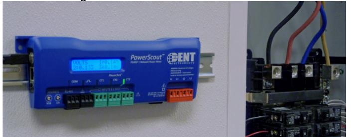
Der PowerScout 3037 wird aus der Messspannung versorgt und erfordert keine externe Stromversorgung. Der Spannungsbereich kann zwischen 80-600V (Phase-Phase) liegen. DENT's patentierte PhaseChek™-Schaltung umfasst 3 Bi-Color-LED Anzeigen, die den phasenrichtigen Stromwandleranschluss bestätigen.
